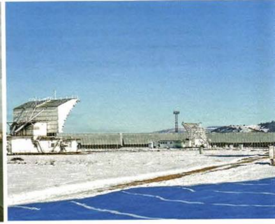
Радиотелескоп РАТАН-600 выполняет наблюдения, используя длины волн от 1 до 50 см (радиодиапазон)
